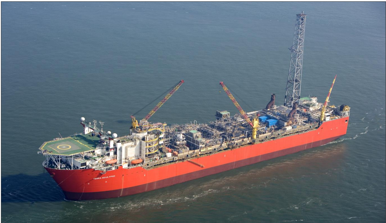
Terra Nova FPSO
